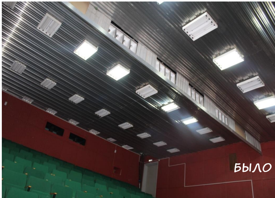
Монтаж и установка световых ламп для зрительного зала
